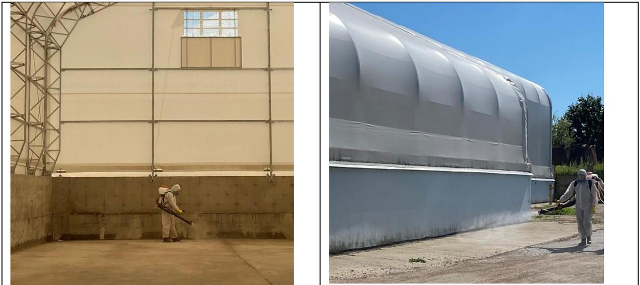
**Рисунок 2 – Дезинсекция (влажная обработка) незагруженного зернохранилища и прилегающей территории с помощью моторизованного ранцевого опрыскивателя «STIHL 450»**
